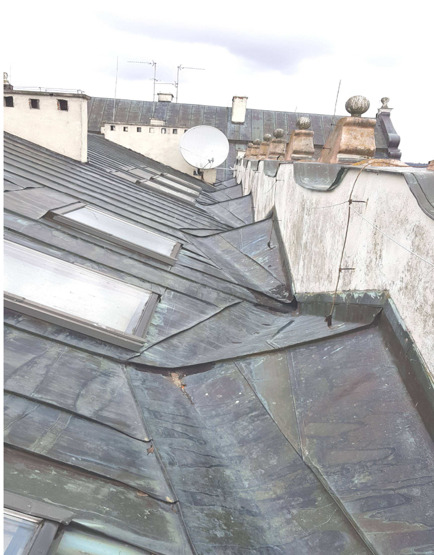
fot. Nr 13 Widok obróbek blacharski z koszami odpływowymi przy attyce południowo-wschodniej (tylnej)
