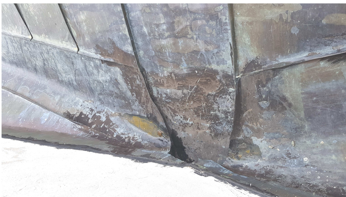
fot. Nr 14 Stan obróbek i koszy kozubów przy otworze żygacza-
