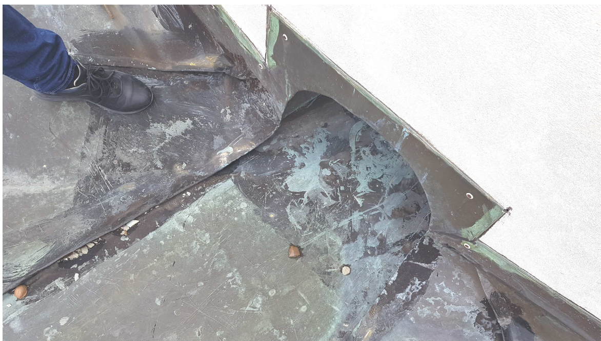
fot. Nr 17 Obróbki żygaczaego-
