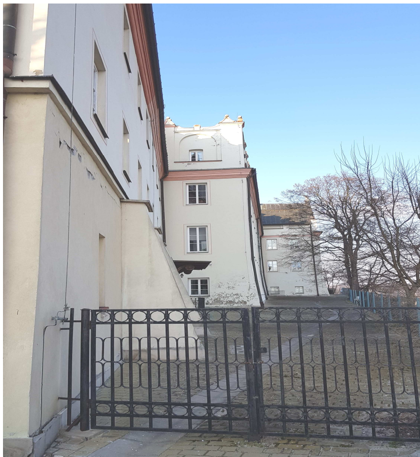
fot. Nr 5 Elewacja tylna (południowo-wschodnia) – widok boczny
