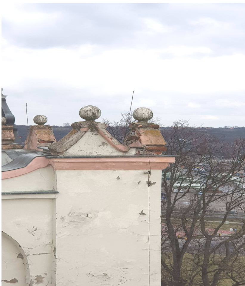
fot. Nr 10 Widok fragmentu attyki od strony południowej
