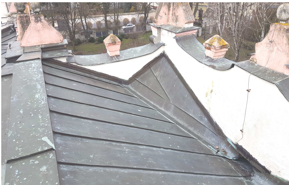
fot. Nr 16 Kozub i pokrycie dachu, obróbki attyki w narożniku ryzalitu południowego-
