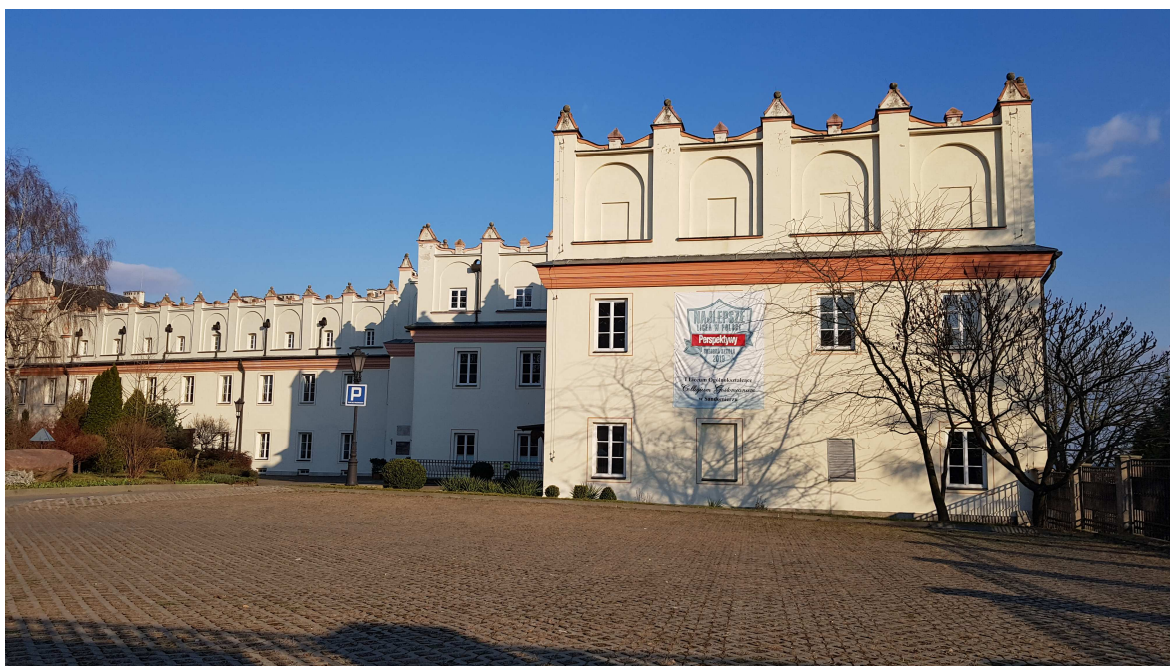
fot. Nr 3 Elewacja północno-zachodnia – widok na część południową z salą gimnastyczną
