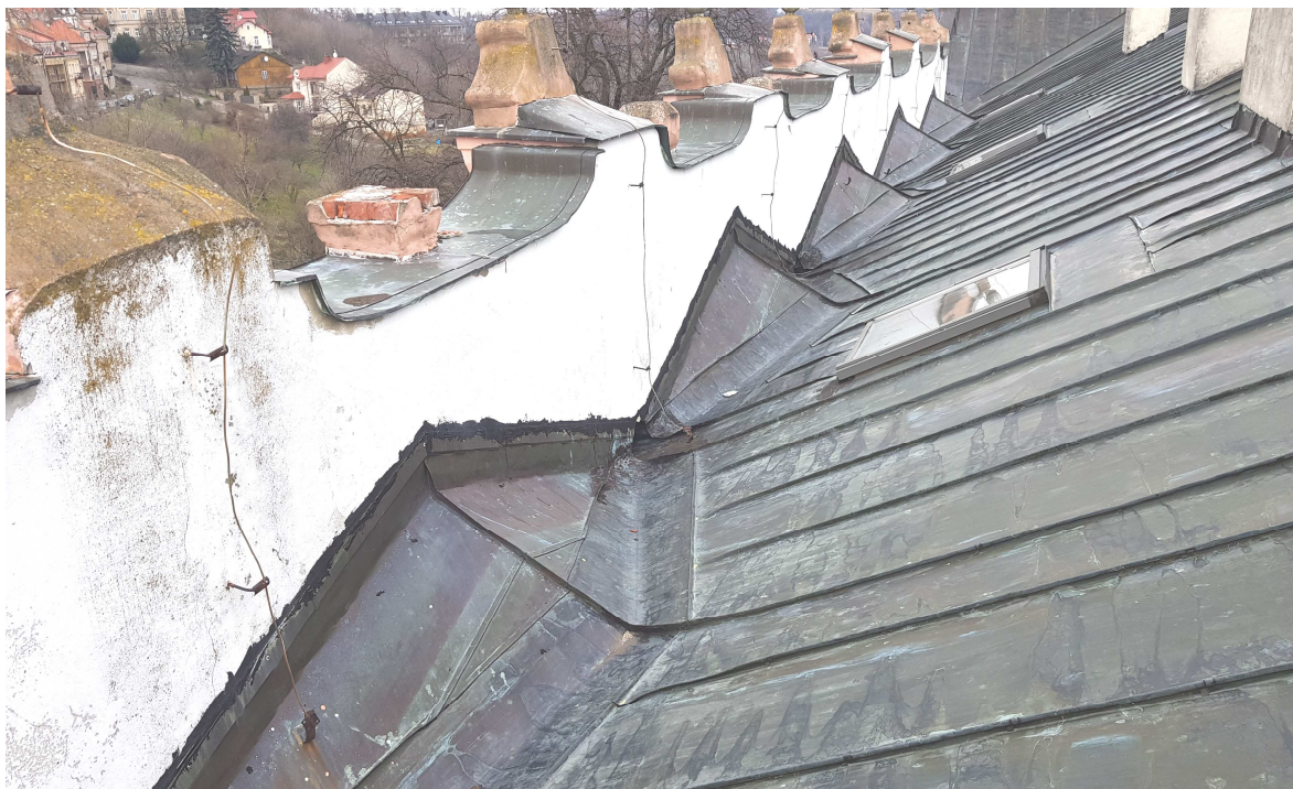
fot. Nr 11 Widok pokrycia dachu i attyki od strony frontowej, północno-zachodniej
