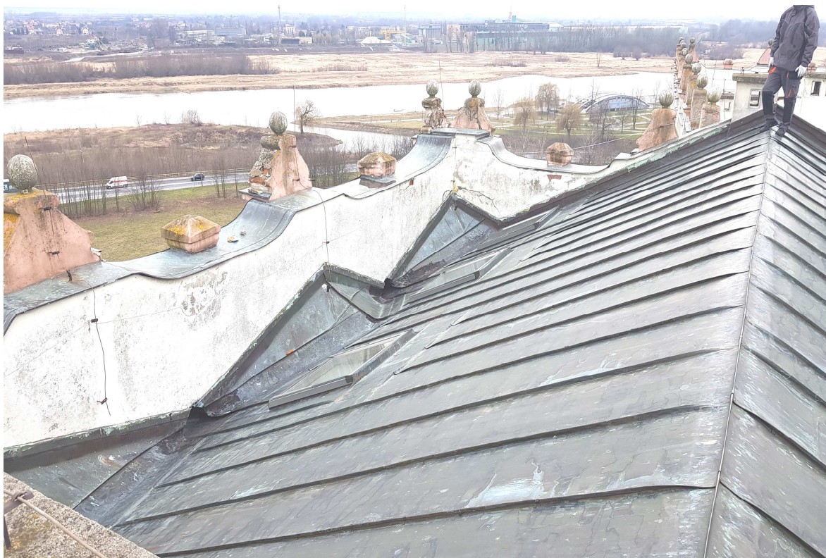
fot. Nr 12 Widok pokrycia dachu i attyki od strony frontowej, południowo-wschodniej
