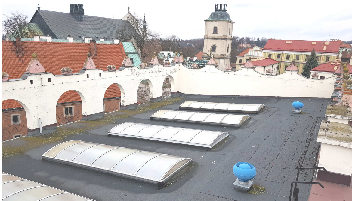
fot. Nr 20 Widok stropodachu z poliwęglanowymi świetlikami pokryciem papowym nad salą gimnastyczną- - widok w kierunku zachodnim
