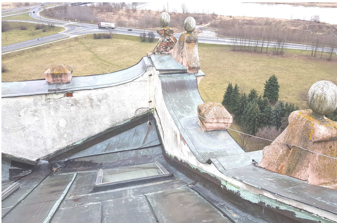
fot. Nr 15 Obróbki blacharskie i pokrycie dachu w narożniku południowo-wschodnim-
