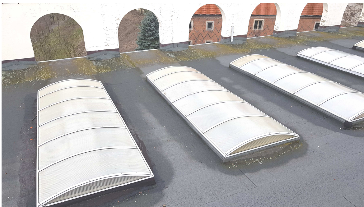
fot. Nr 19 Widok stropodachu z poliwęglanowymi świetlikami pokryciem papowym nad salą gimnastyczną-
