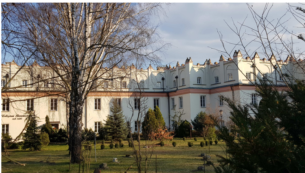
fot. Nr 2 Elewacja frontowa północno-zachodnia z widokiem ryzalitu od strony południowej
